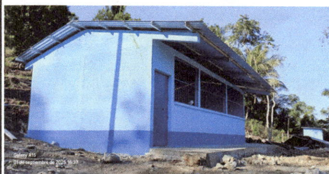
Foto 4: Cambio de la puerta de madera a metal
