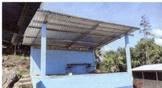
Foto 5: Cambio del techado del escenario y cambio de estructura de madera a metal
