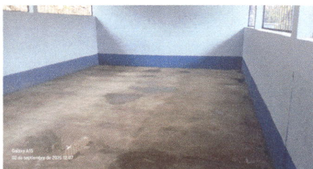
Foto 3: Cambio de piso
