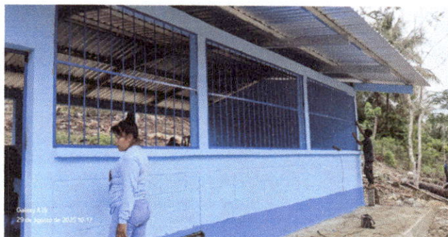
Foto 2: Cambio de ventanas tela de maya a balcón
